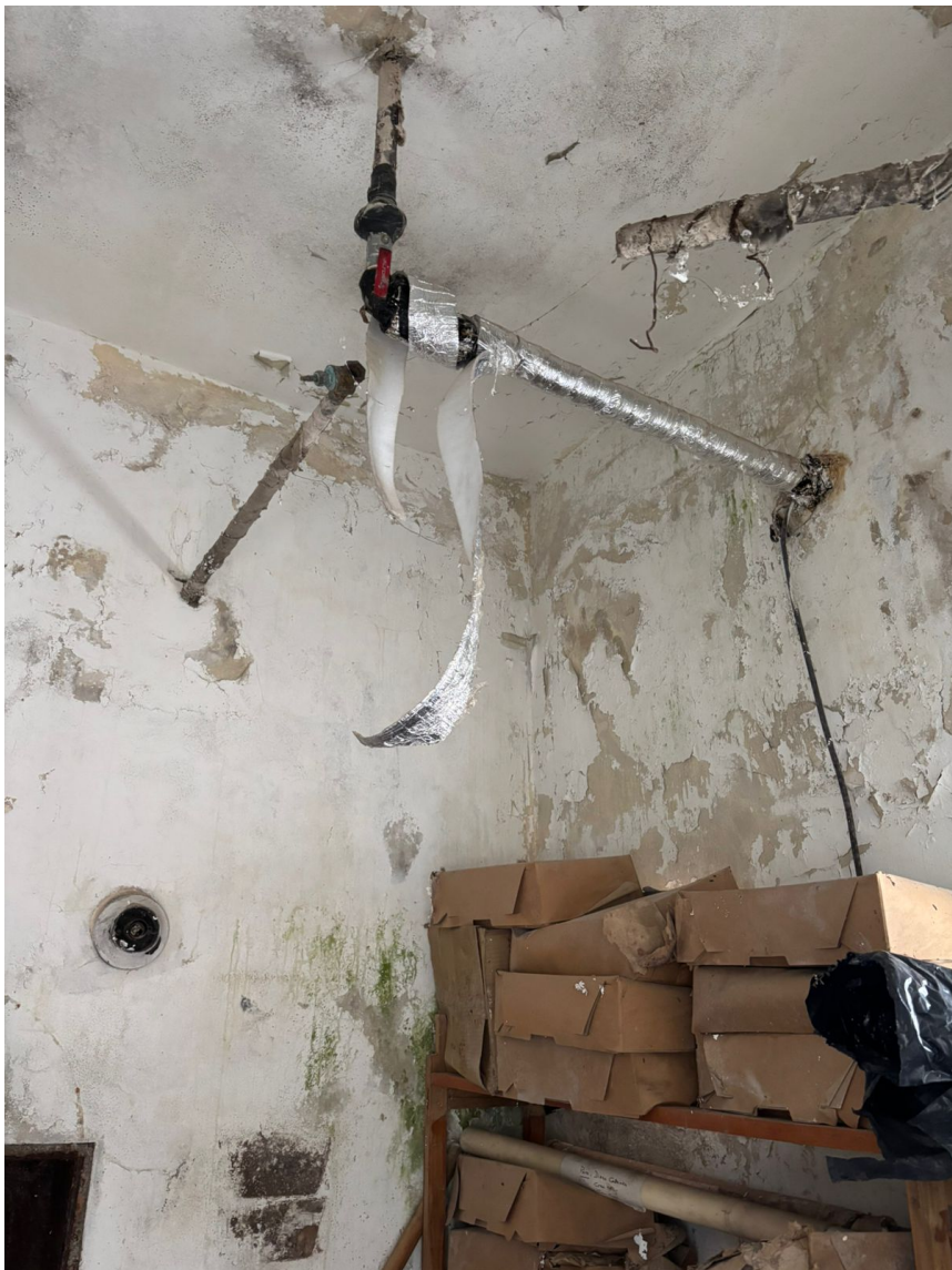
Foto desde el interior de la sala donde está la bajada actualmente
